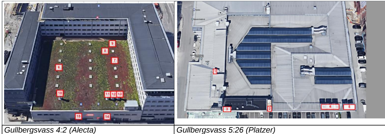
Figur 5 Närliggande fastigheter med fläktar på taken
